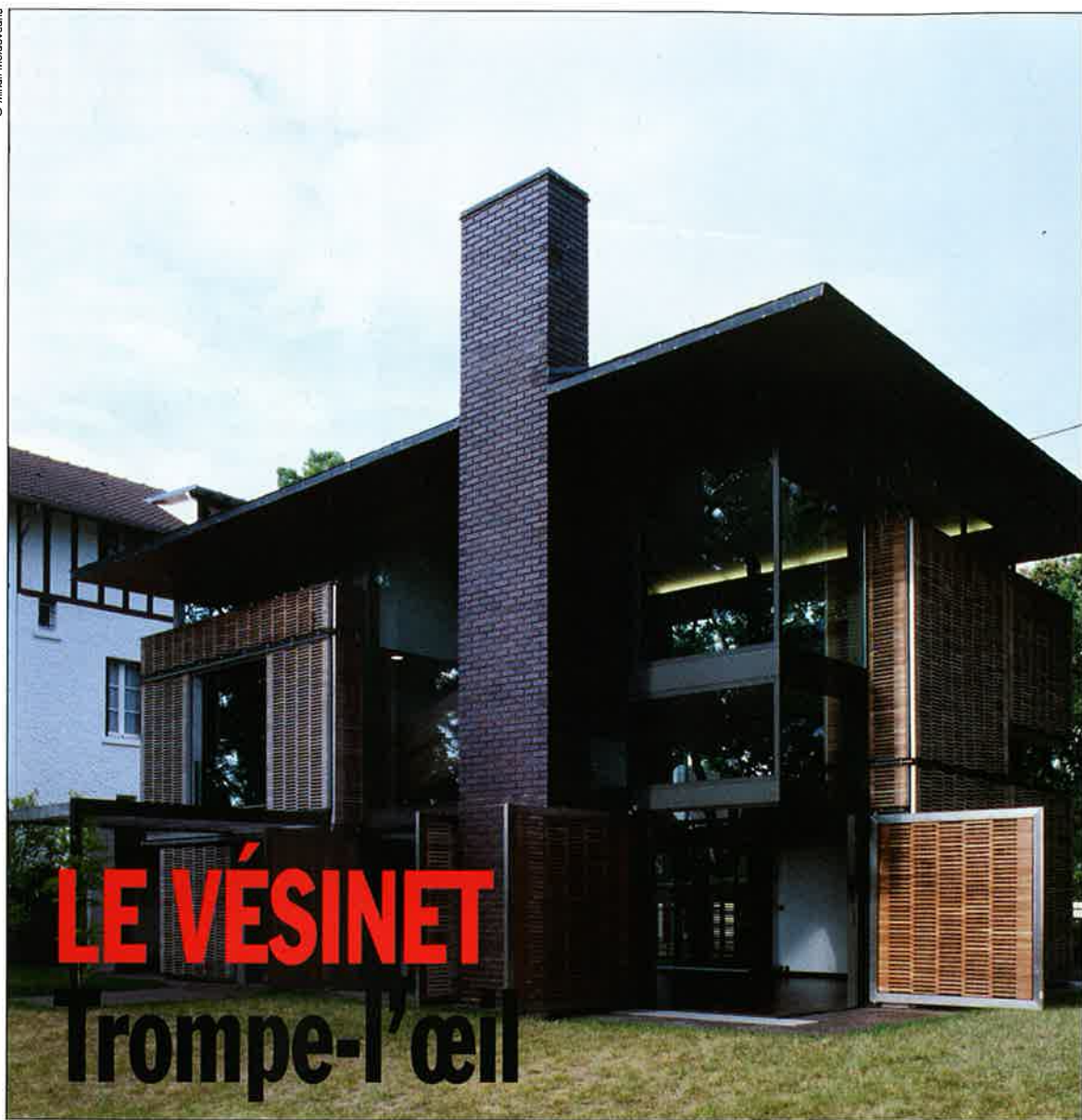
Les panneaux en iroko cerclés d'acier soulignent la géométrie de la maison.
