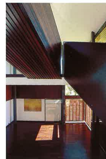
Les deux volées de marches de l'escalier. Celle de droite dessert la mezzanine ; celle de gauche conduit aux chambres du niveau supérieur.
