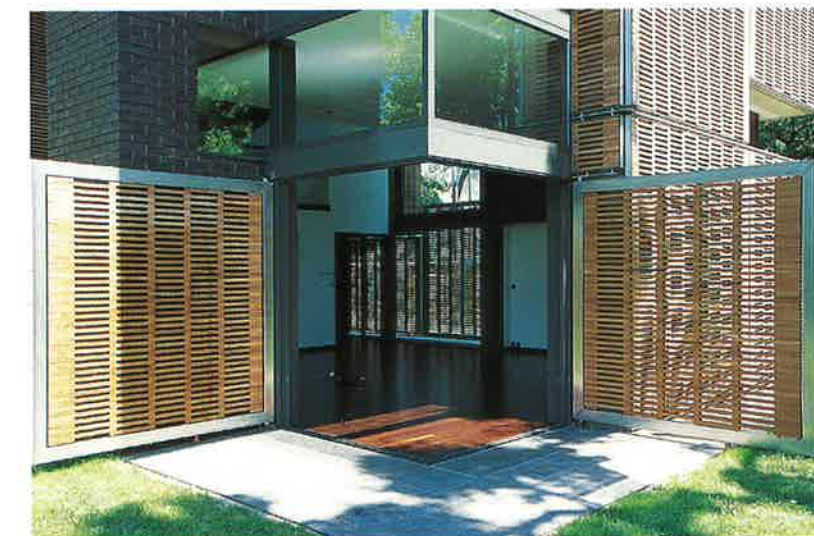
Ouverture totale du séjour à l'angle de la maison.
