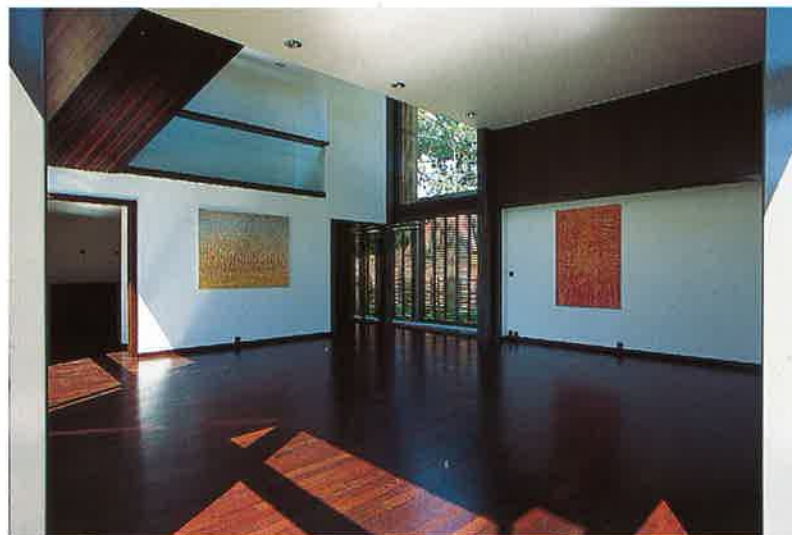
En haut à gauche, l'escalier desservant la mezzanine est réalisé en bois lamellé-collé de wengé.
