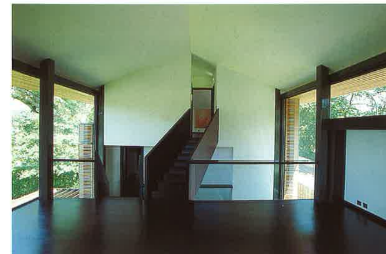
Vue depuis la mezzanine. Notez à droite le garde-corps en verre avec sa main courante en bois.
