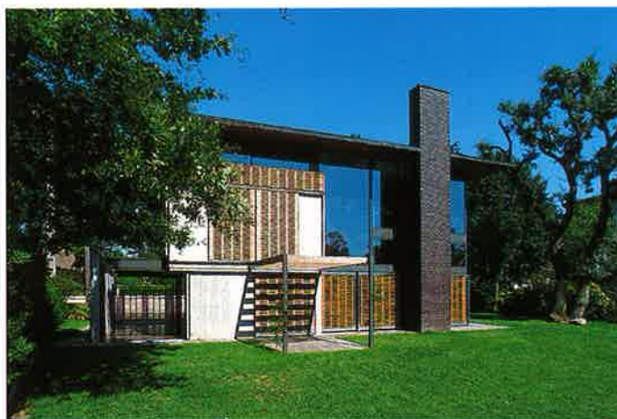
Sur la partie gauche de la façade, les panneaux de bois coulissent pour fermer la maison.
