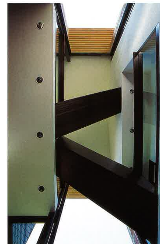
L'escalier vu d'en dessous.
